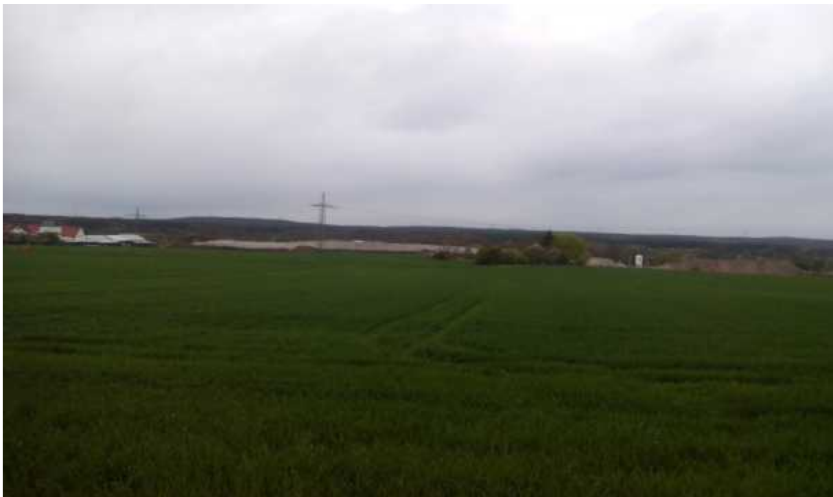
Abbildung 13: Blick von der Birkenallee auf den Lärmschutzwall, Bauabschnitt 1 (Süd), links im Bild
